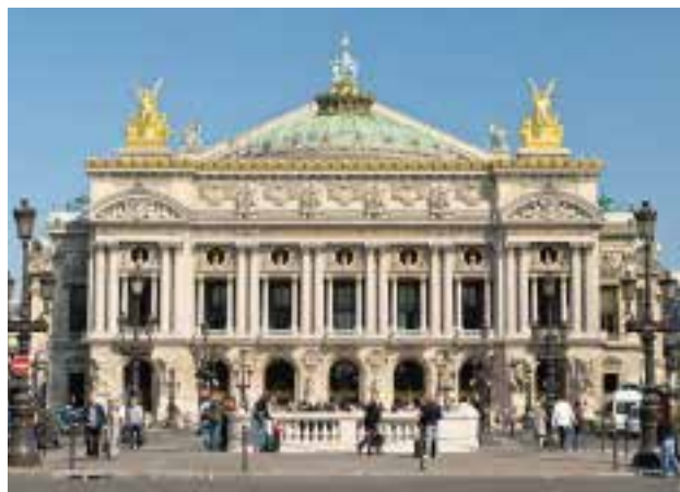
▲ La facciata neobarocca del Teatro Opéra Garnier, la sede storica dell'Opera parigina, specificamente adibita alla rappresentazione del Grand opéra.
